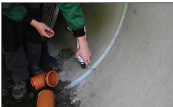
Abb. 86: Versiegelung der Zwischenräume der Betonröhrensegmente
