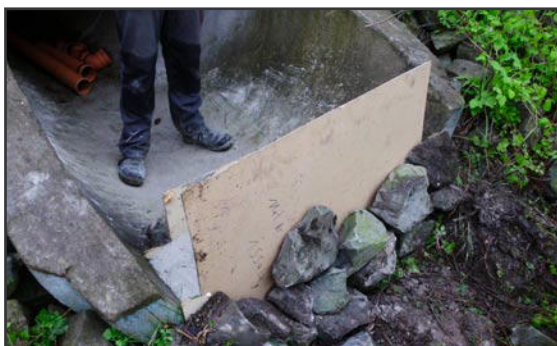
Abb. 85: Aufmauerung des Wasserstaus zur Rückhaltung von Regenwasser
