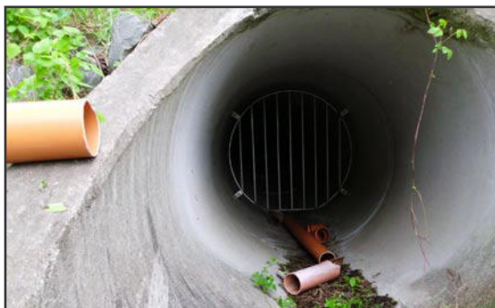
Abb. 84: Erstellung der Rohrleitung zur Zuführung von Regenwasser
